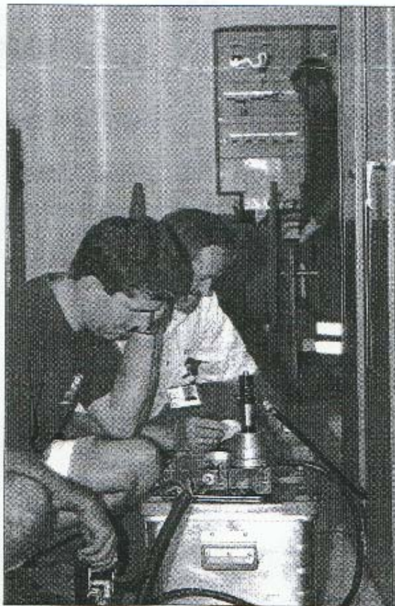
Le système MicroJET pousse et souffle les mini-câbles sous haute pression dans leur tube protecteur.
